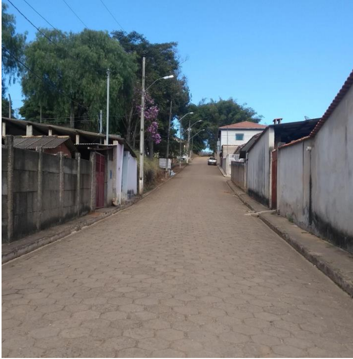
19 – Rua João Augusto Pereira - Sertãozinho
